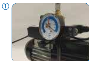
Collegamento con pompa per vuoto
